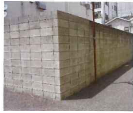
補強コンクリートブロック造 (コンクリートブロックに鉄筋が入った塀)
