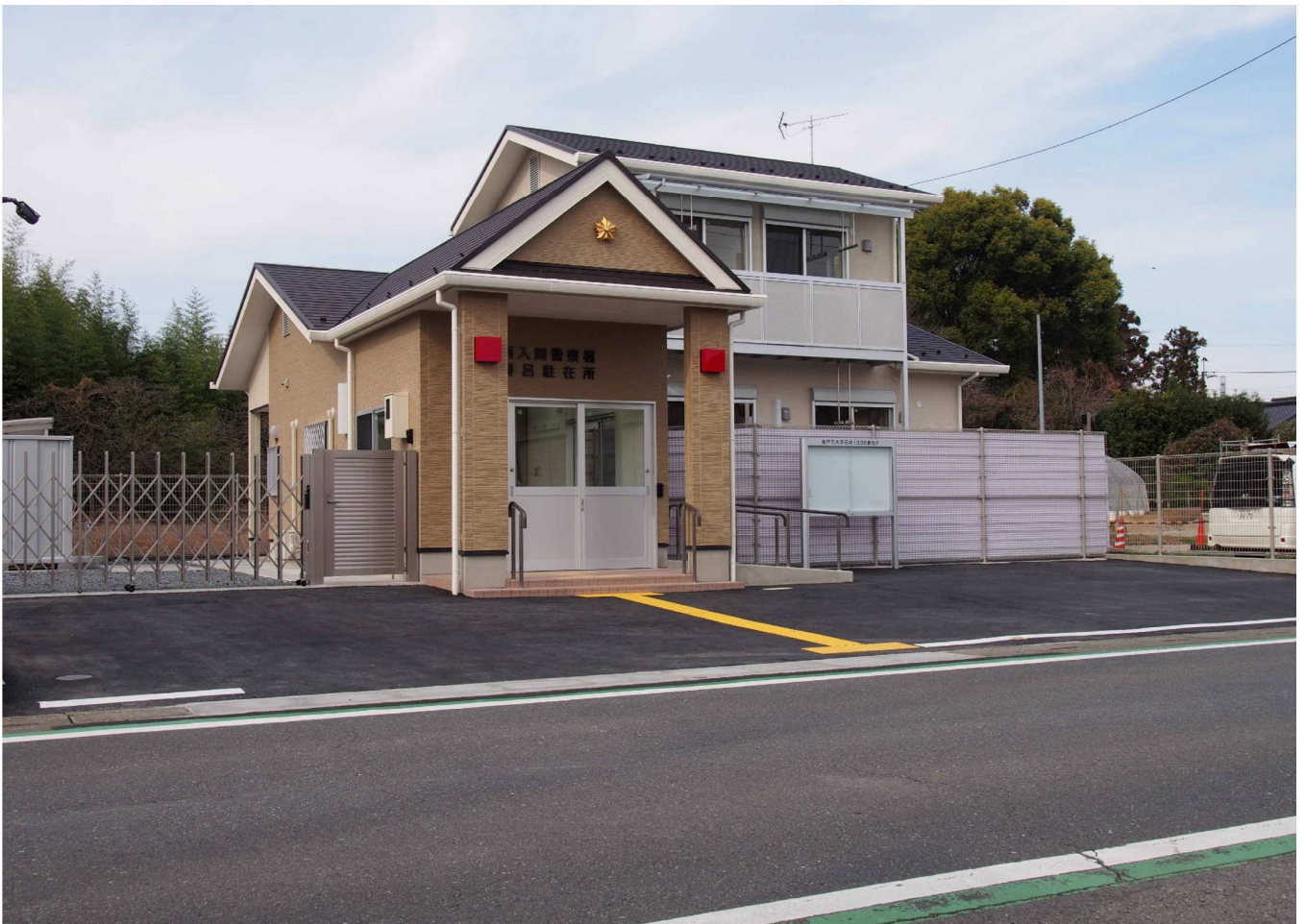
埼玉県西入間警察署勝呂駐在所
